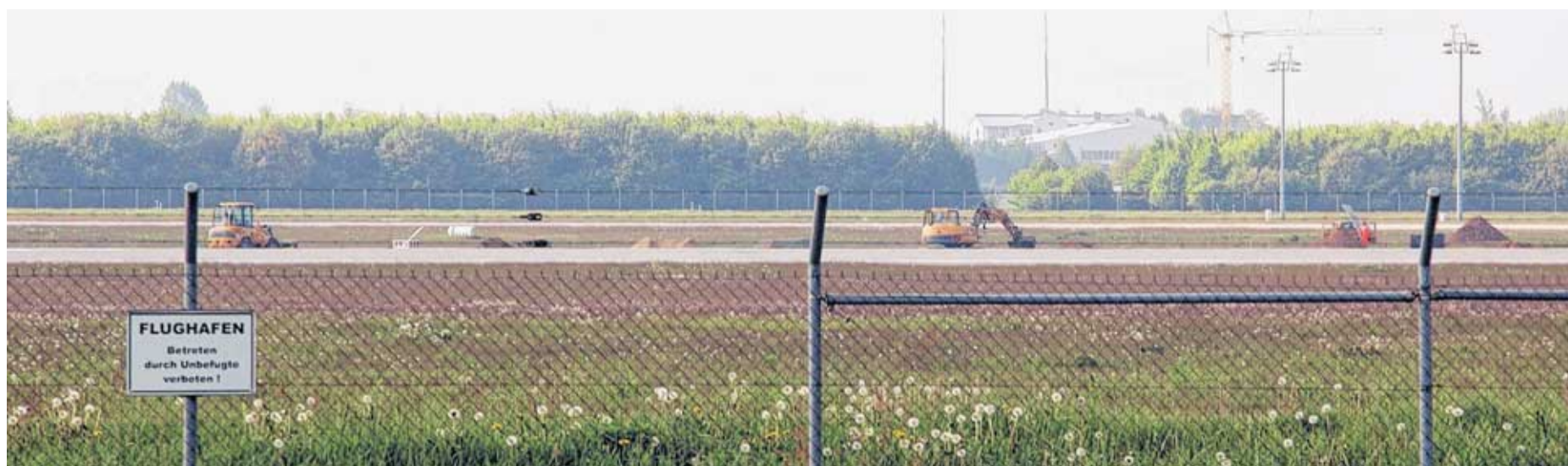
Bagger sind derzeit an der Nordbahn des Flughafens Leipzig/Halle zu sehen. Offensichtlich wird gebaut. Deshalb dürfte es in den Schkeuditzer Nordgemeinden relativ ruhig zu gehen, da wegen der Baustelle hier kein Flugzeug landet oder startet. Foto: Roland Heinrich
