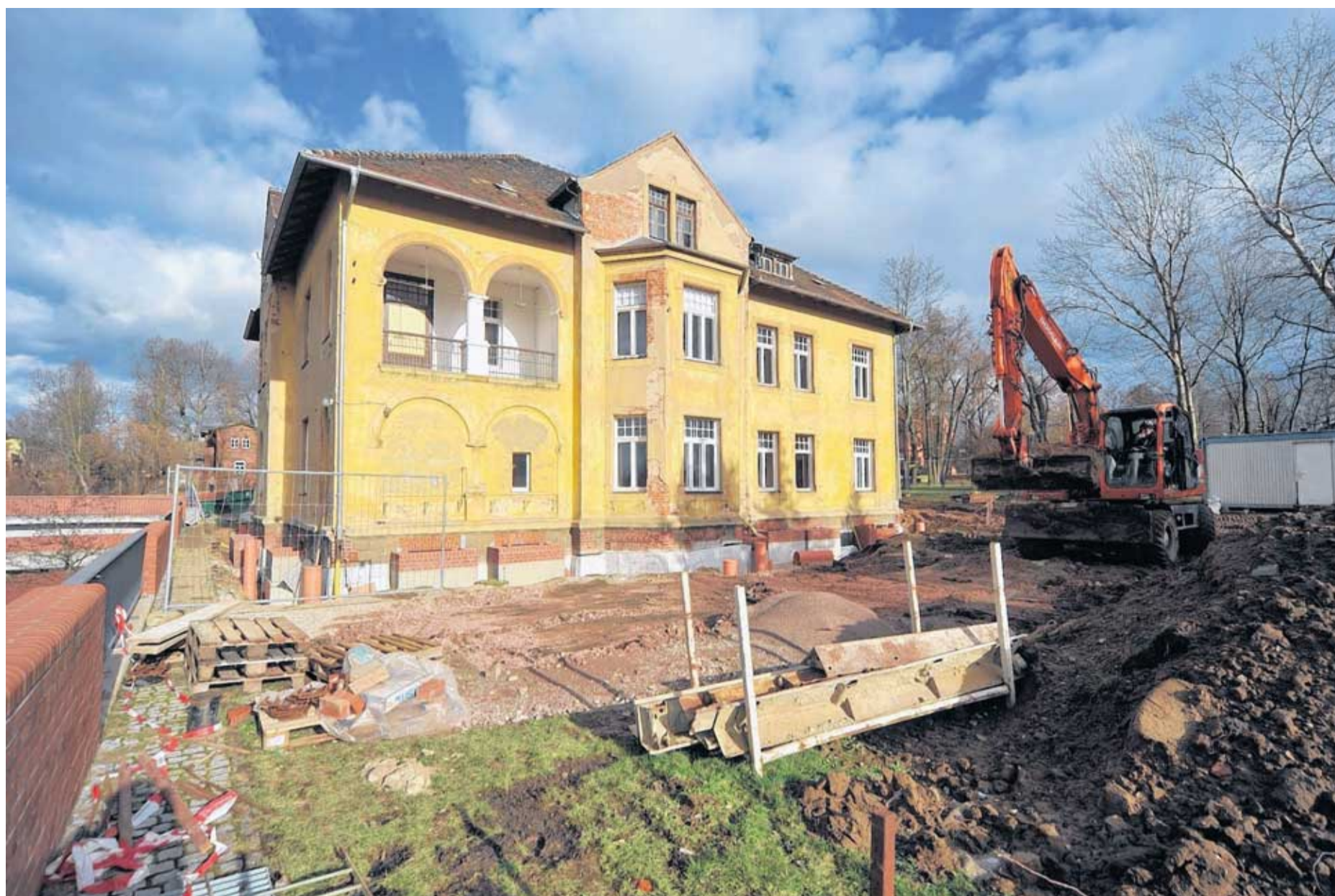
Bis zum Sommer 2015 soll das Haus 4 des Sächsischen Krankenhauses Altscherbitz saniert werden. Etwa 2,2 Millionen Euro bezahlt das Fachkrankenhaus dafür aus eigener Tasche. Zehn Sprechzimmer für die ambulante Behandlung werden hier Platz finden. Foto: Michael Strohmeyer
