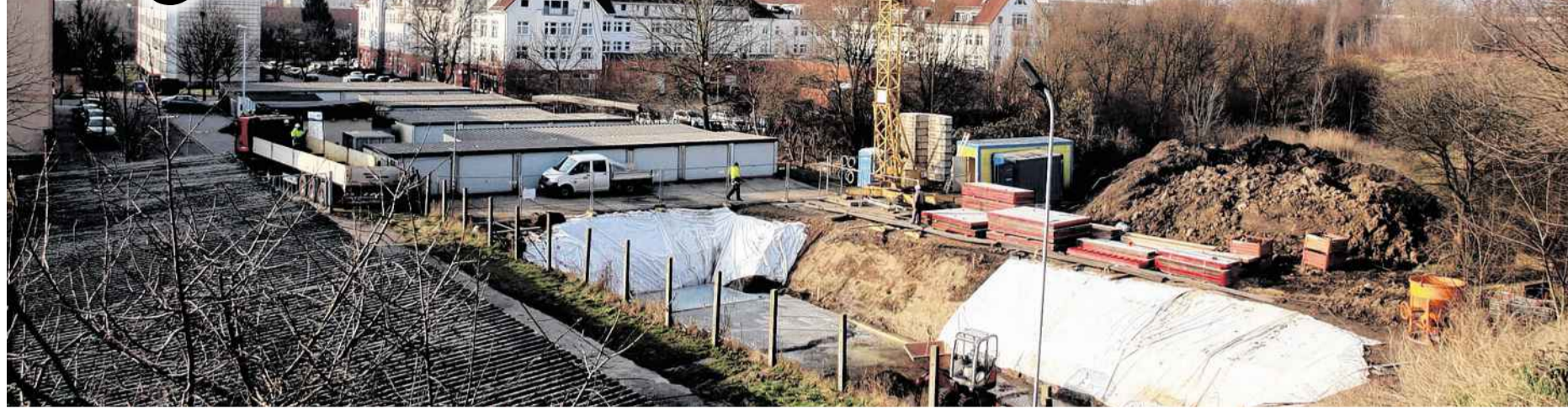
Nahe der Turnerstraße bauen die Kommunalen Wasserwerke Leipzig derzeit ein neues Regenrückhaltebecken.
