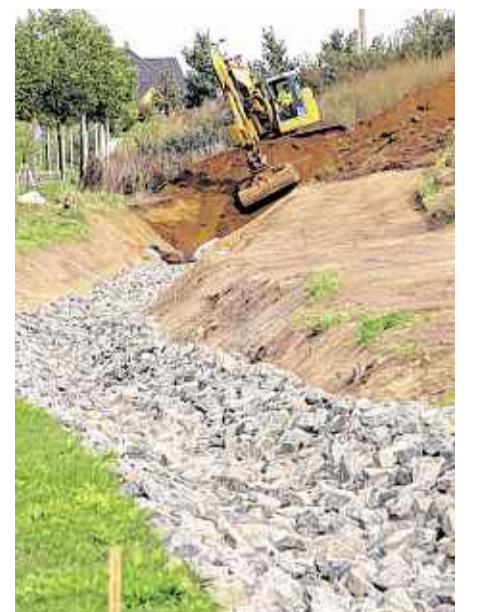
In Auenhain wird derzeit ein Entwässerungskanal gebaut. Foto: André Kempner
